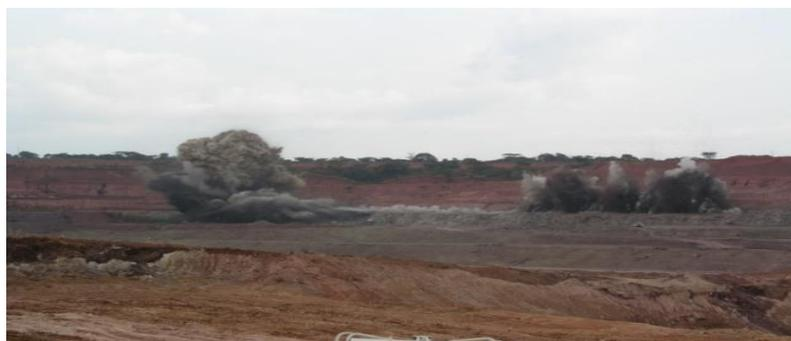
**Figura 18:** Desmonte dos gnaisses com explosivos.
